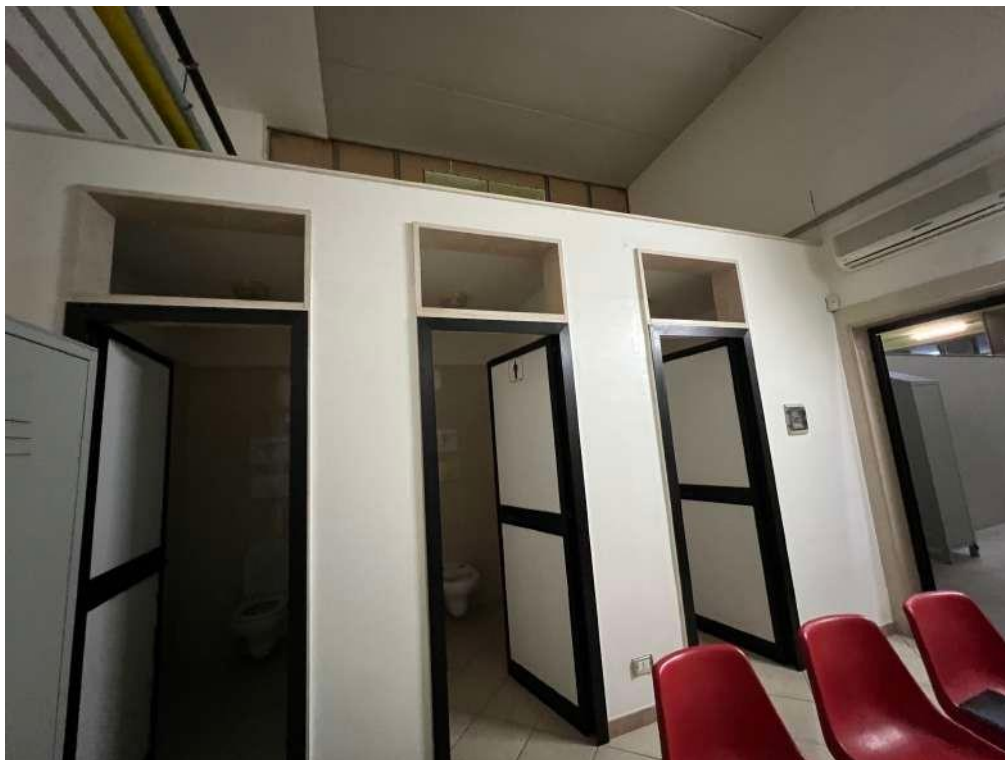
Foto n° 73 Servizi e bagni "9".
