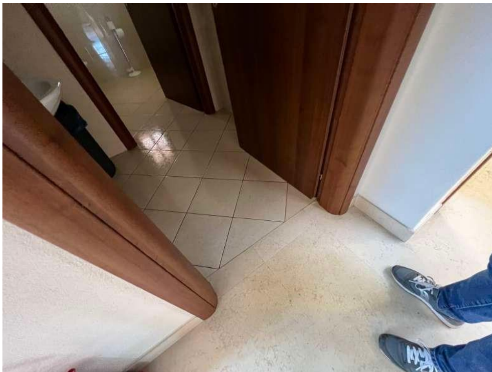
Foto n° 34 Particolare delle pavimentazioni dell'antibagno e hall.
